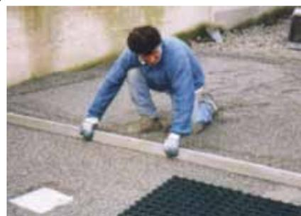
Fig. 2 Staggiatura e preparazione del fondo.
